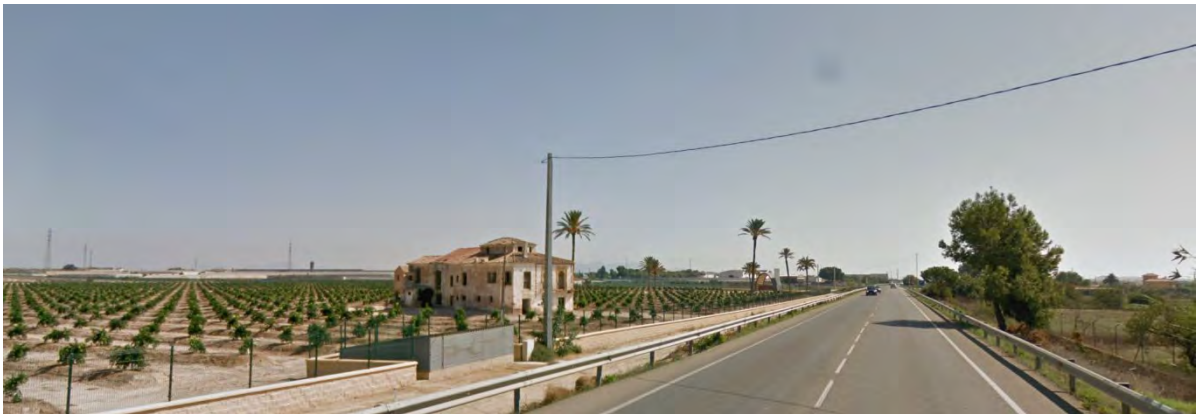
** ARQUETA FINAL DEL TRAMO PROYECTADO QUE CONECTA CON TRAMO DE TUBERÍA EXISTENTE HASTA DEPÓSITOS EL HACHO
